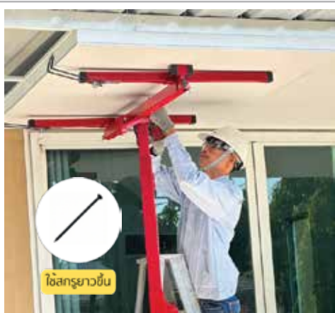
ติดตั้งเหมือนฝ้าเดิม
